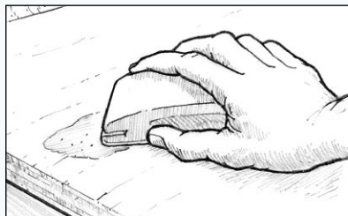
Figuur 23 Schuur de uitgeharde plamuur in de gewenste vorm.
