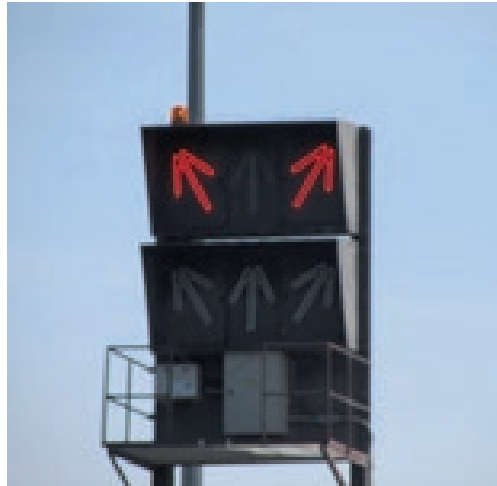
Verkeerslicht op de zuidelijke muur van het Montgomerydok.
