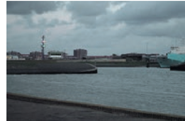
De seinmast ten noorden van de voorhaven.
